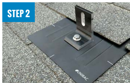
STEP 2 INSTALL L-FOOT
